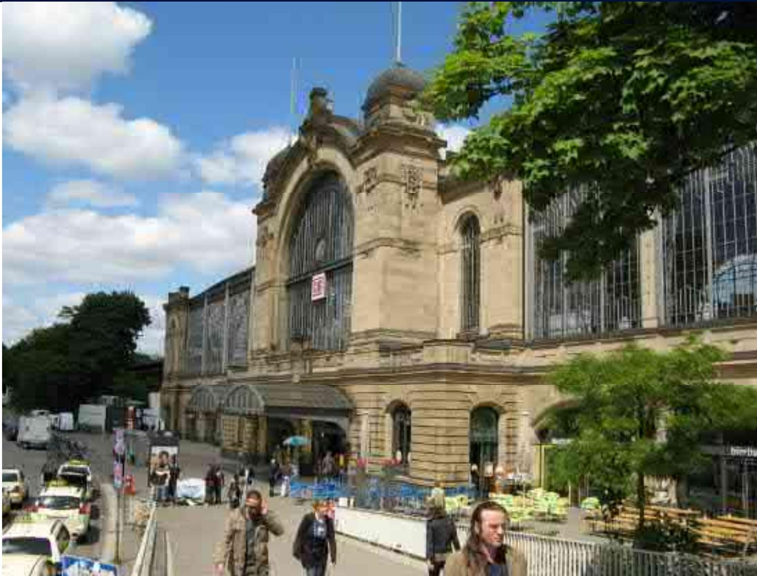
Die Fassade des Dammtor-Bahnhofs ist aus dem Weiler-Sandstein (Schilfsandstein, Trias) ausgebaut, der noch heute in Sinsheim-Weiler (bei Heidelberg) abgebaut wird.
